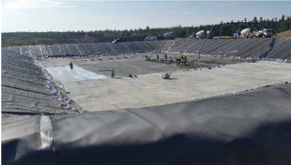
Photo - Travaux d'infrastructure 2017 – Bassin de lixiviat #3
