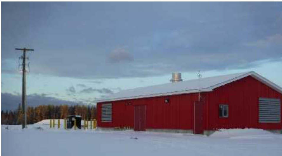
Photo - Travaux d'infrastructure 2017 – Bâtiment des soufflantes
