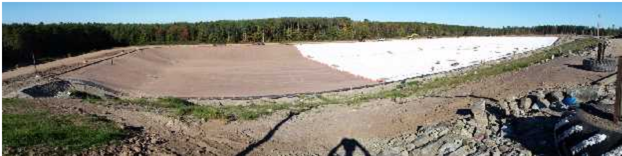
Photo - Travaux d'infrastructure 2016 – Cellule #13
