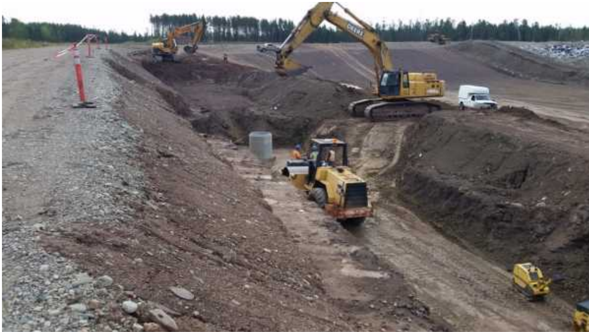
Photo - Travaux d'infrastructure 2016 – Installation des conduites émissaires
